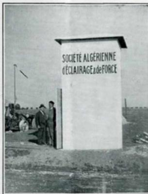
FIG. 4. — Le poste de transformation construit spécialement pour alimenter les appareils d'électro-motoculture.
